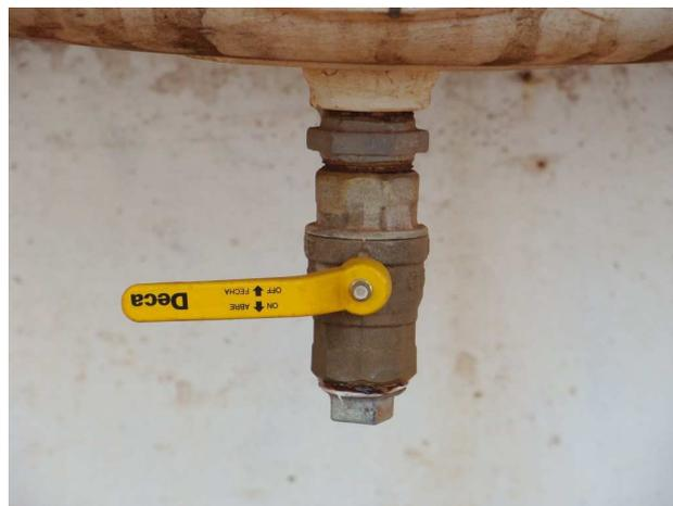
**Figuras 22/23 - Coleta de amostra por tubulação de descarga e registro de drenagem**
